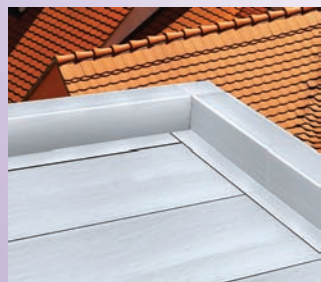
Lajes não transitáveis
